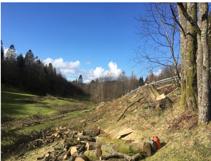
En rekke trær måtte fjernes for det nye sikkerhetsnettet på hull 3 kunne settes opp.
