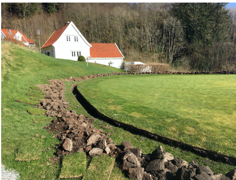
Grøfter til vanningsanlegget rundt green nr. 6.
