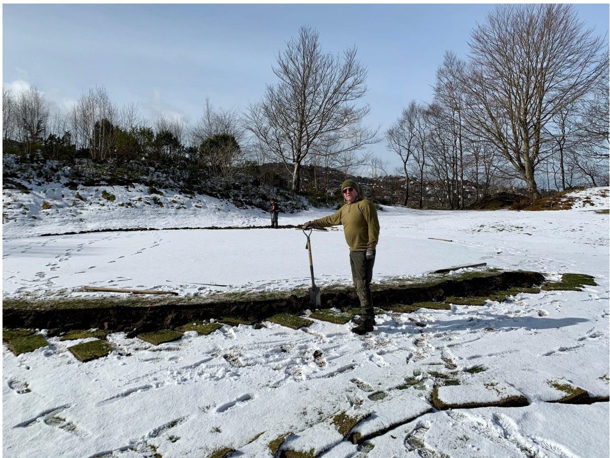
Dugnadsarbeid. Terje Mellingsen graver grøft til vanningsanlegget på hull 5.
