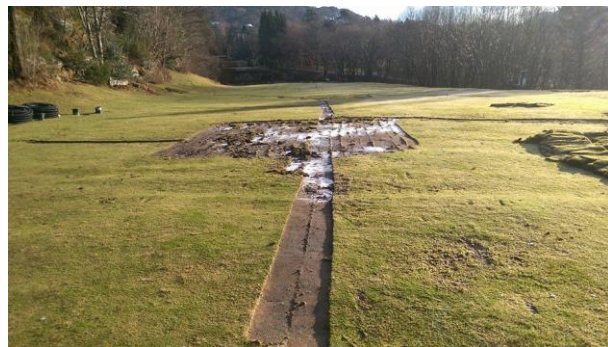
Dreneringsarbeid i gang på hull 4
