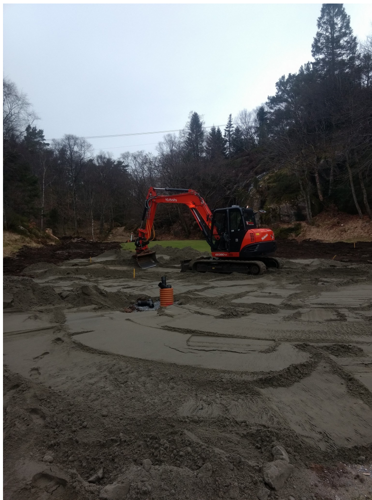
Dreneringsarbeid og forbedret greenområde på hull 4.
