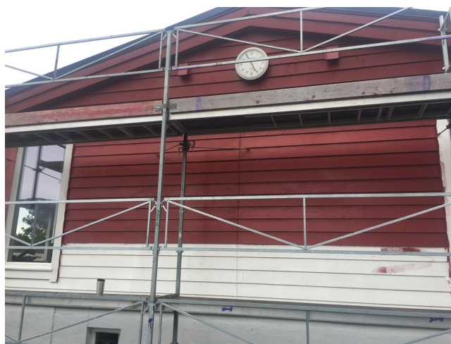
Klubbhuset ble malt, ødelagte vinduer og råttent kledning ble byttet, og peisestuen ble bedre isolert.
