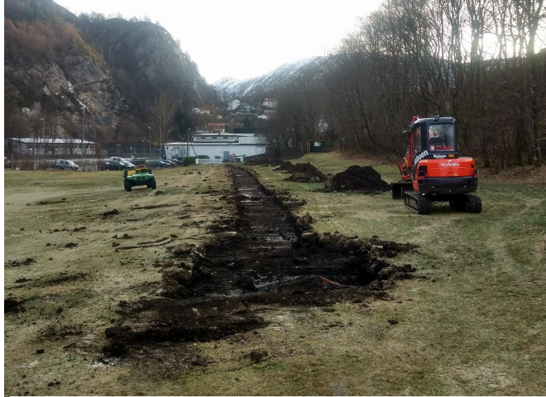
Ny sti til teestedene på hull 8/17 under arbeid vinteren 2018.
