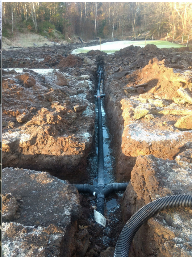
Dreneringsarbeid rundt greenen på hull 4.
